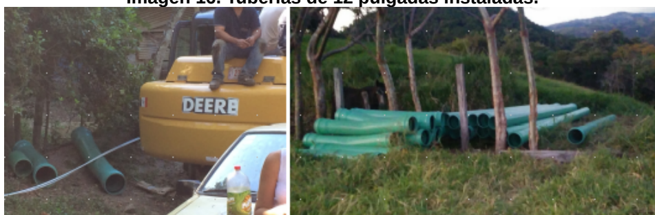
Imagen 16. Tuberías de 12 pulgadas instaladas.
