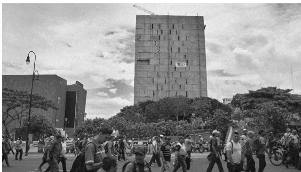
Panorámica del nuevo edificio de la Asamblea Legislativa desde la Plaza de la Democracia. Fotografía de Mauricio Inostroza.
