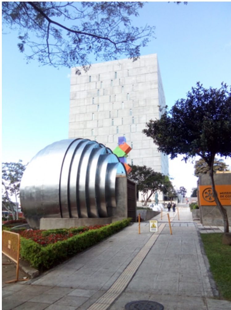
Panorámica de la fachada principal del edificio legislativo desde el costado del Museo Nacional. Fotografía de la autora.
