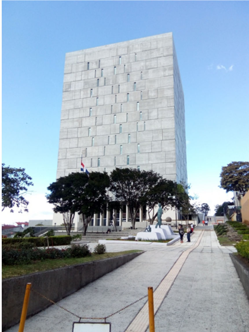
Panorámica de la fachada principal del edificio legislativo. Fotografía de la autora.
